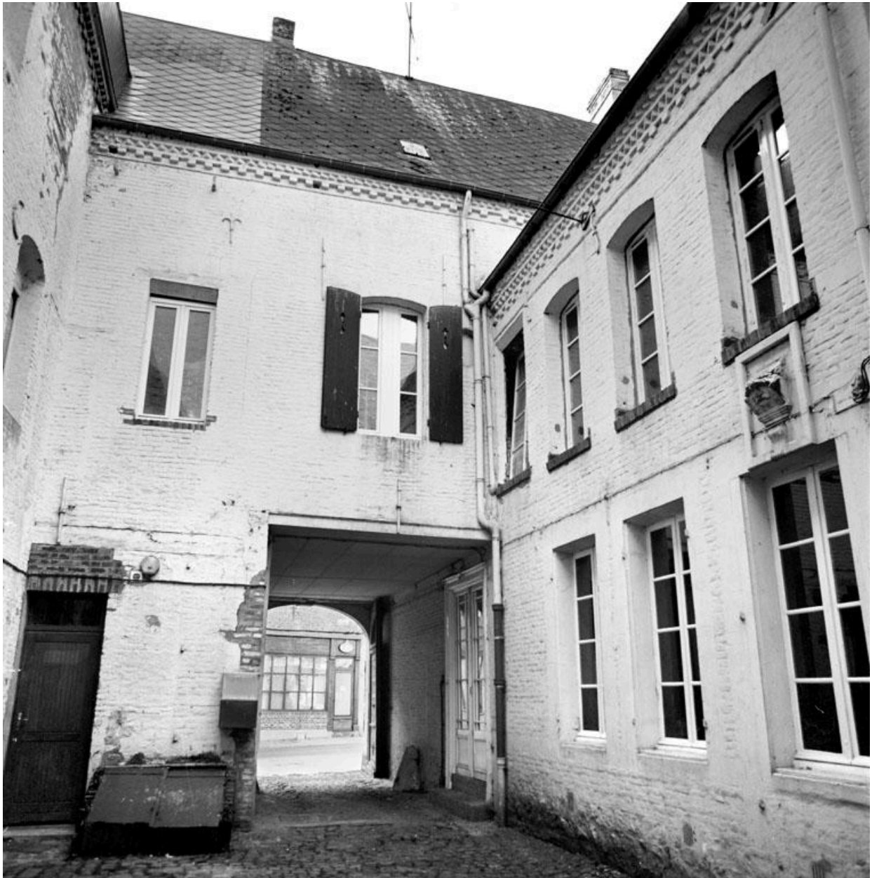
Vue des façades du corps de logis principal et de l'aile gauche sur cour.
