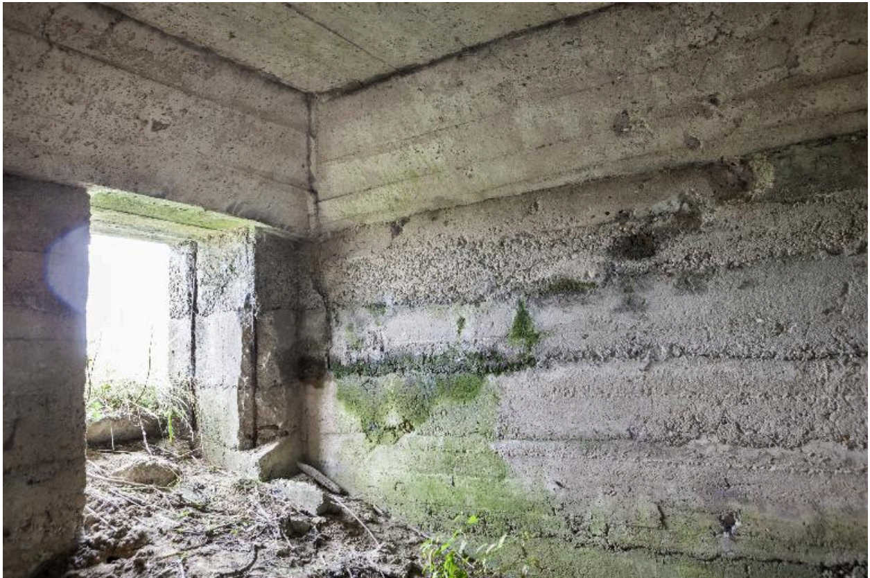
Soute à munition sud.
