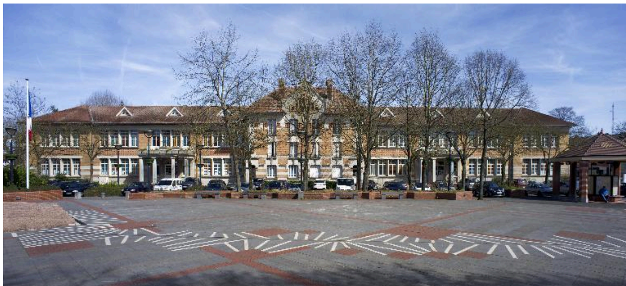
Vue générale de la façade principale donnant sur la place.
