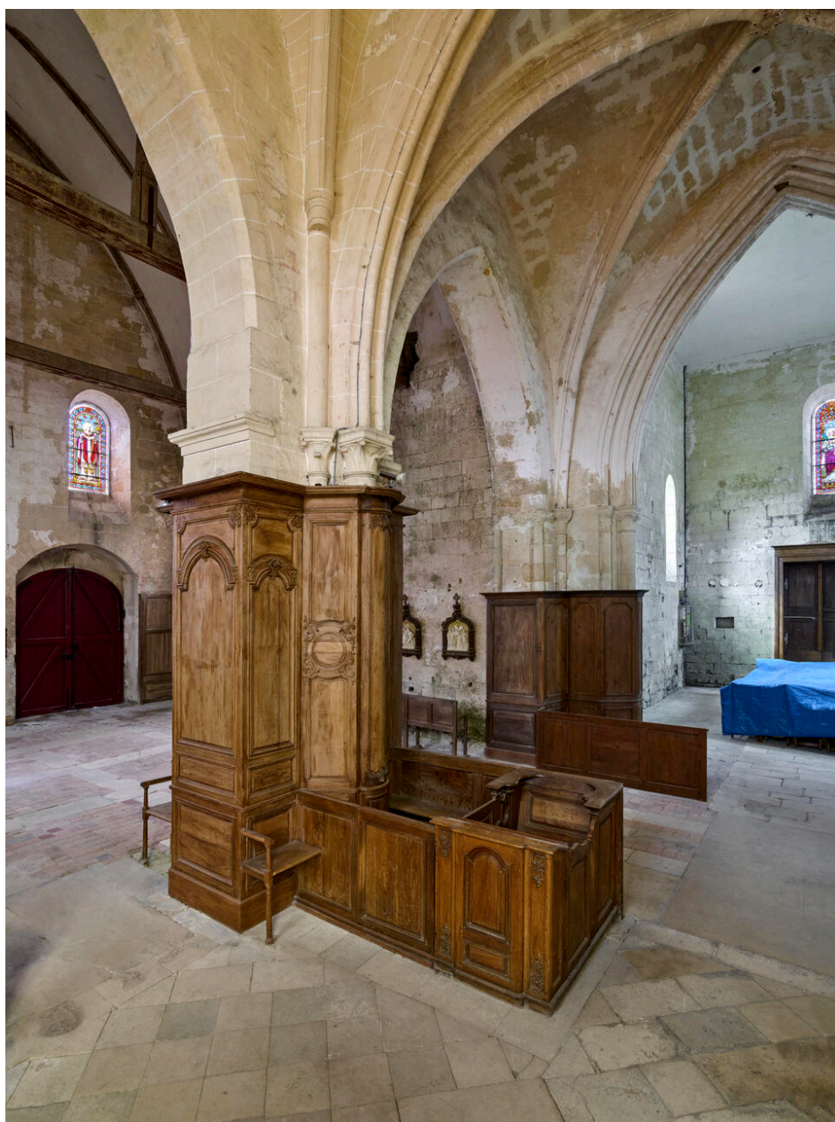
Vue du lambris des piliers sud de la croisée du transept.
