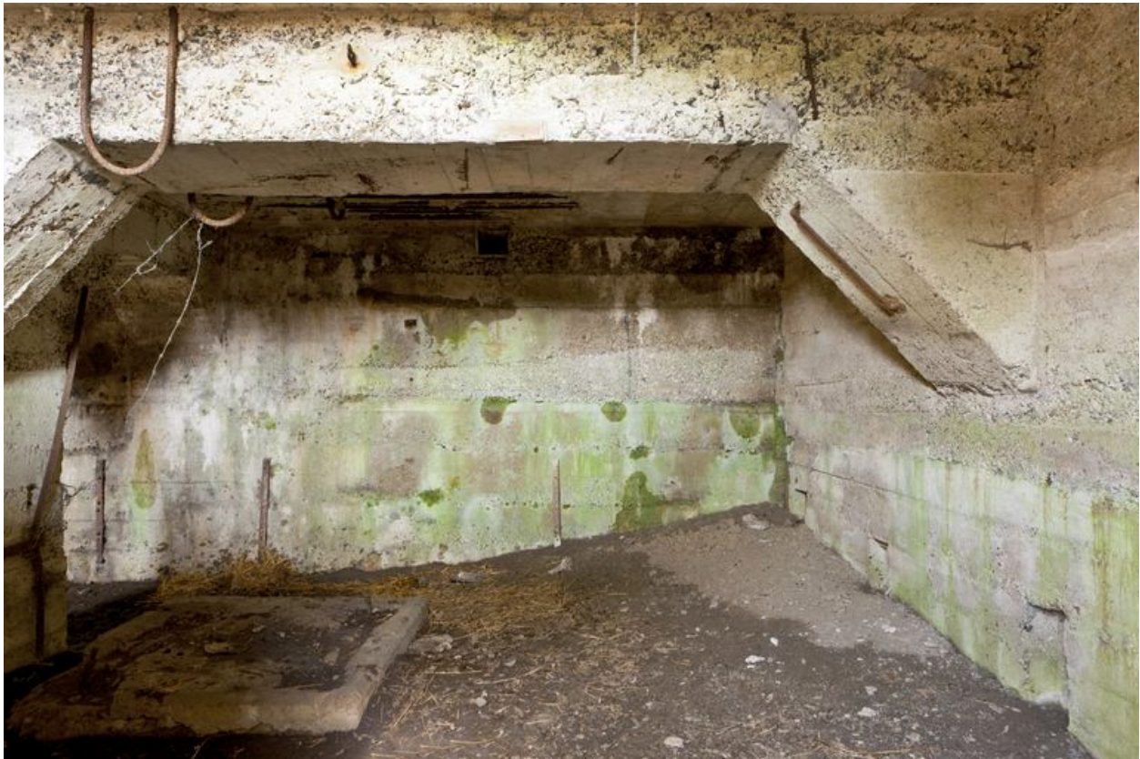
Salle secondaire, vers le nord. A gauche, le socle bétonné d'une pompe aujourd'hui disparue
