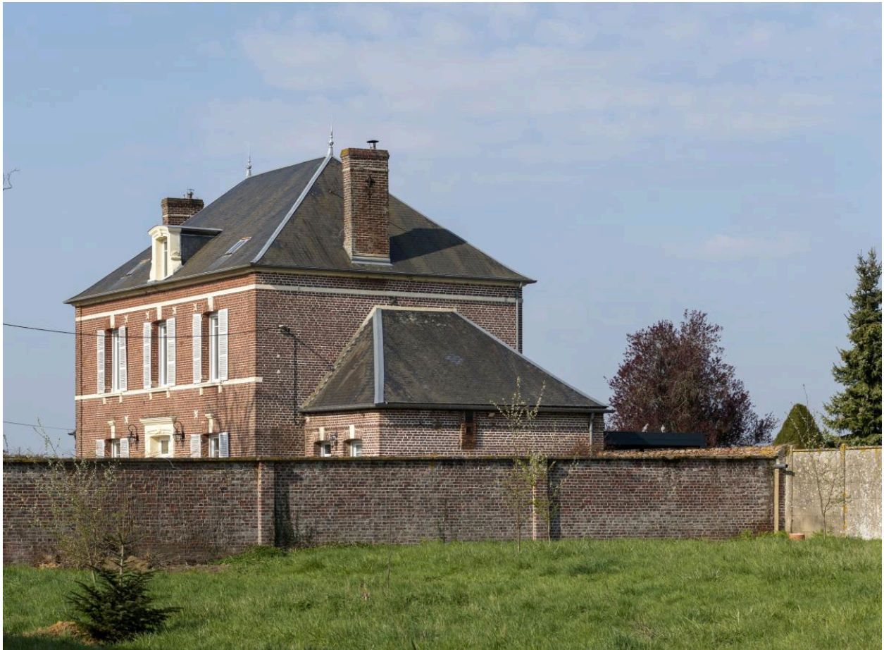
Logis d'une ancienne ferme, n°5 rue de l'Église, vue depuis le nord-est.
