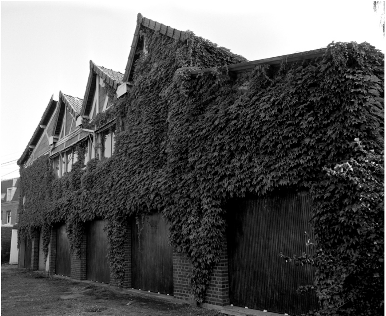
L'atelier de fabrication coustruit en 1932 : façade ouest à trois sheds.
