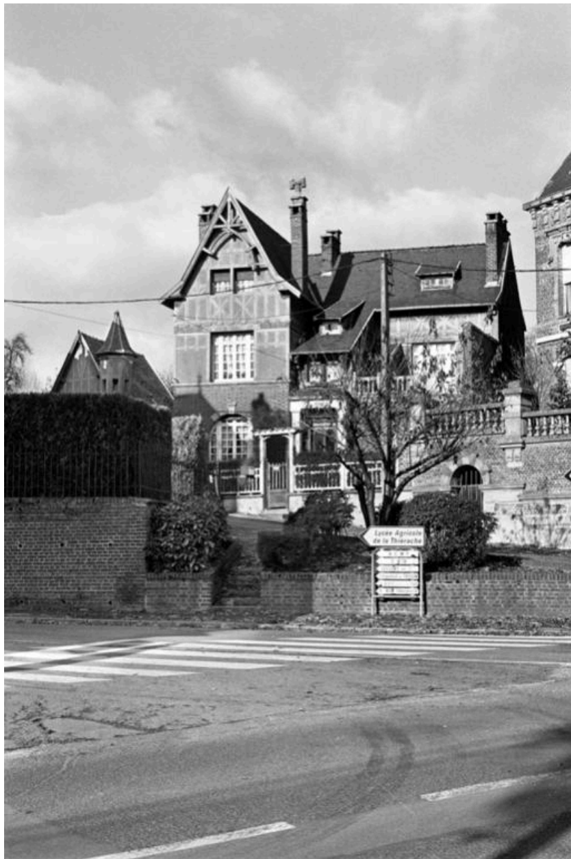
Vue générale de la façade principale, prise depuis la RN 2.
