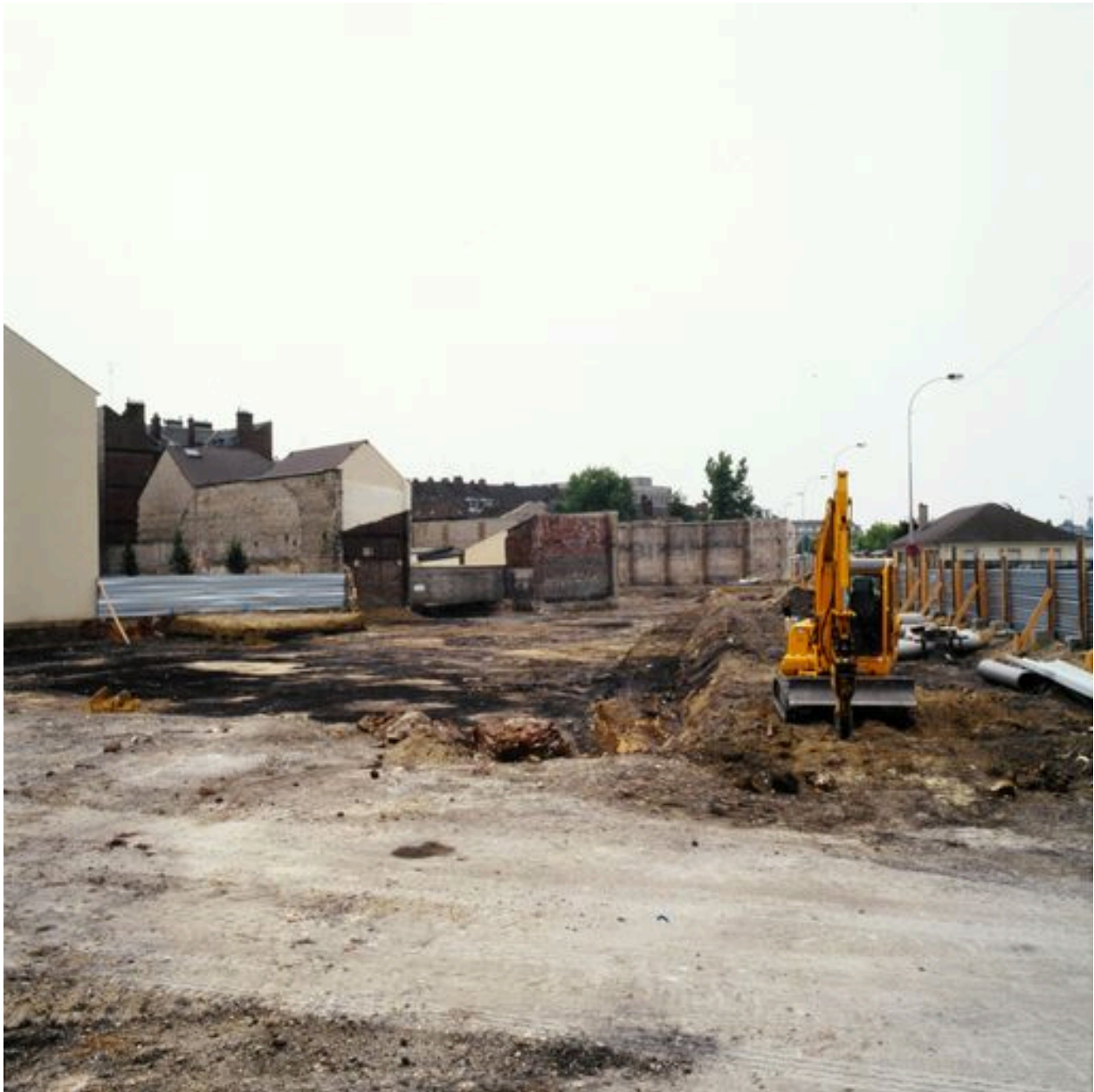
Démolition des anciens entrepôts.
