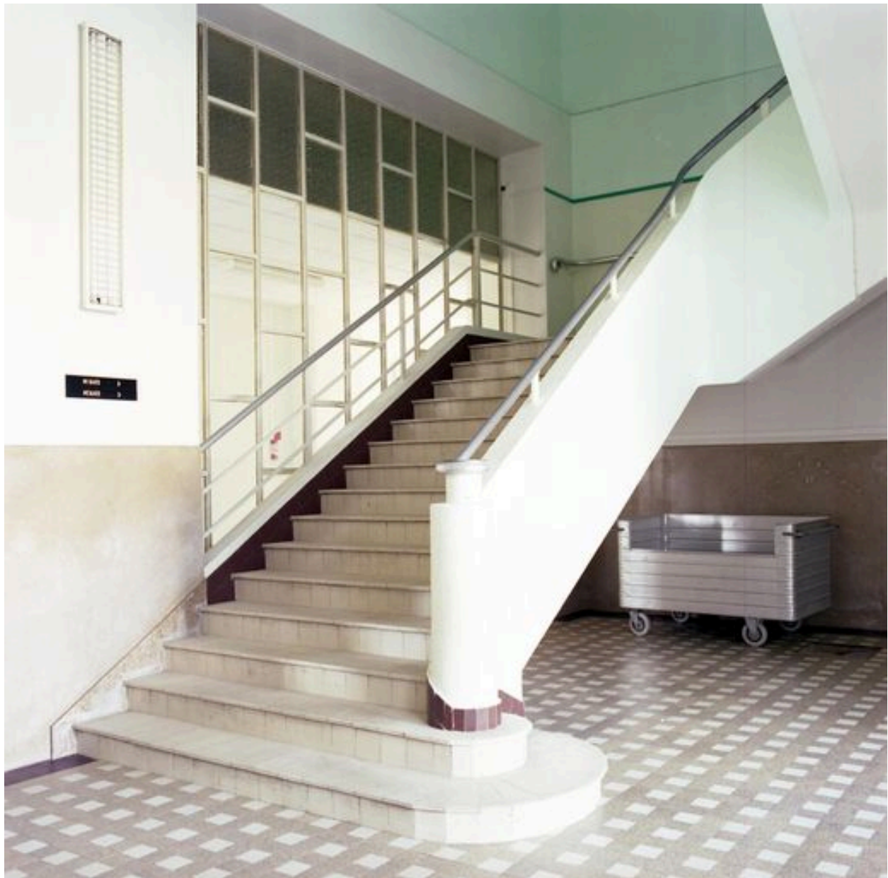
Corps de logis principal, escalier d'accès au 1er étage situé à proximité du bâtiment abritant la piscine d'eau de mer couverte.
