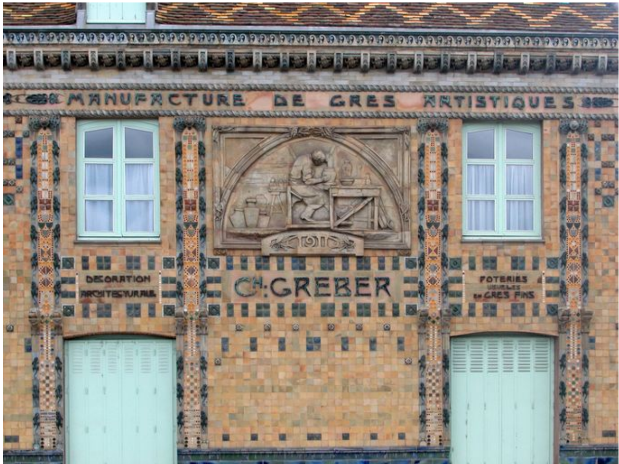
Détail de la partie centrale de la façade sur rue.
