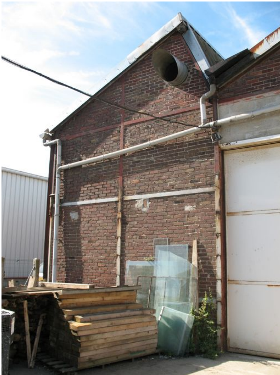
Détail d'une travée couverte en shed de l'ancien atelier des fûts d'emballage.
