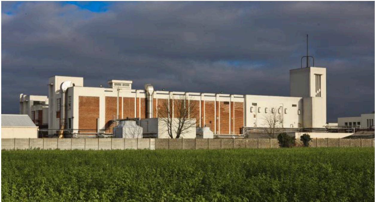
Ateliers de fabrication (H) vers le nord-est depuis le chemin de Molpas.
