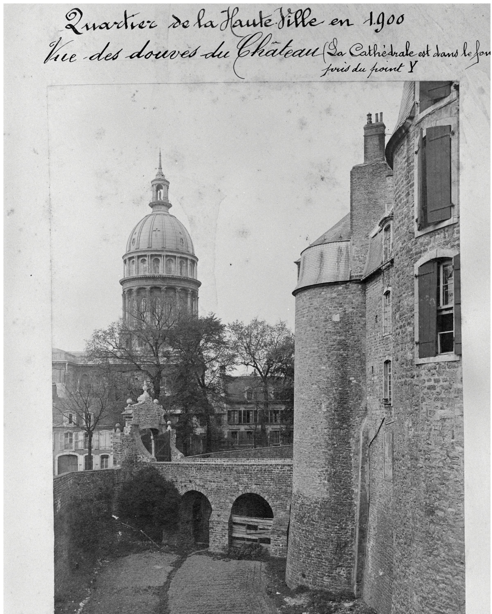
Façade sud-ouest, vue de profil, pont, carte postale ; A.C. Boulogne-sur-Mer, division cartes postales, série "Rues de Boulogne".
