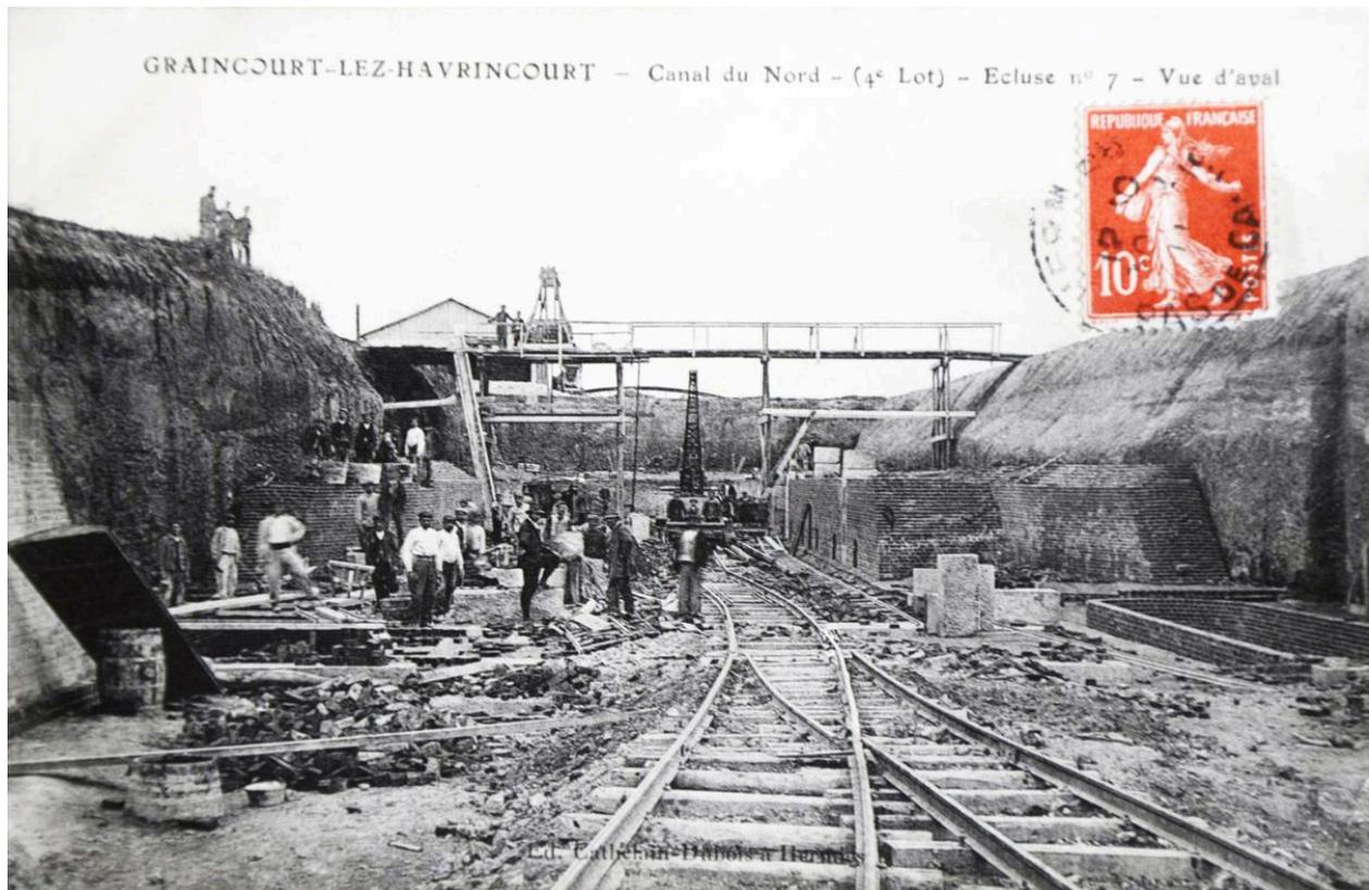
Chantier de l'écluse : réseau ferré technique en fond de fouille et observation de la base des bajoyers en cours de construction, carte postale, entre 1908 et 1914 (collection particulière.)
