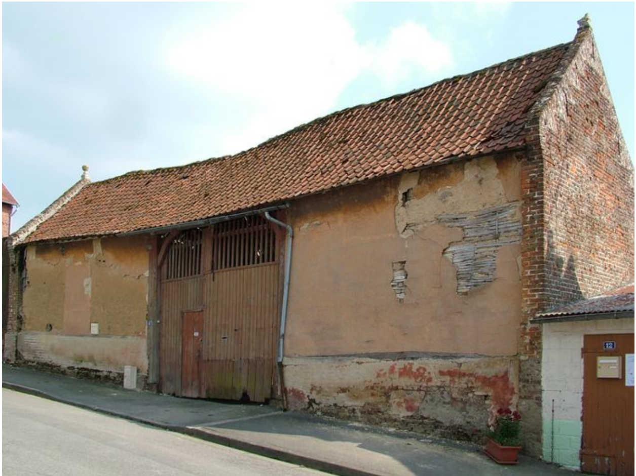
Grange et passage charretier sur rue.
