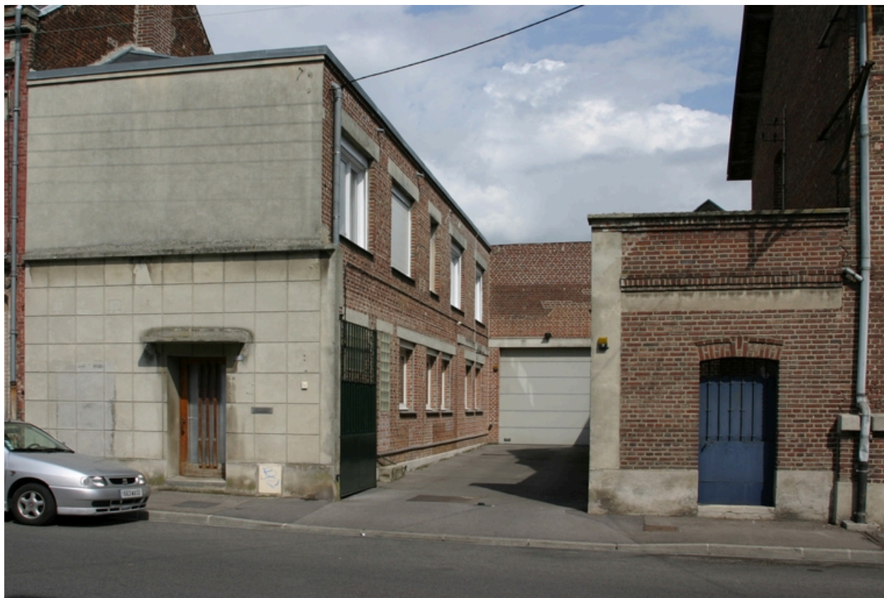
Entrée des ateliers.
