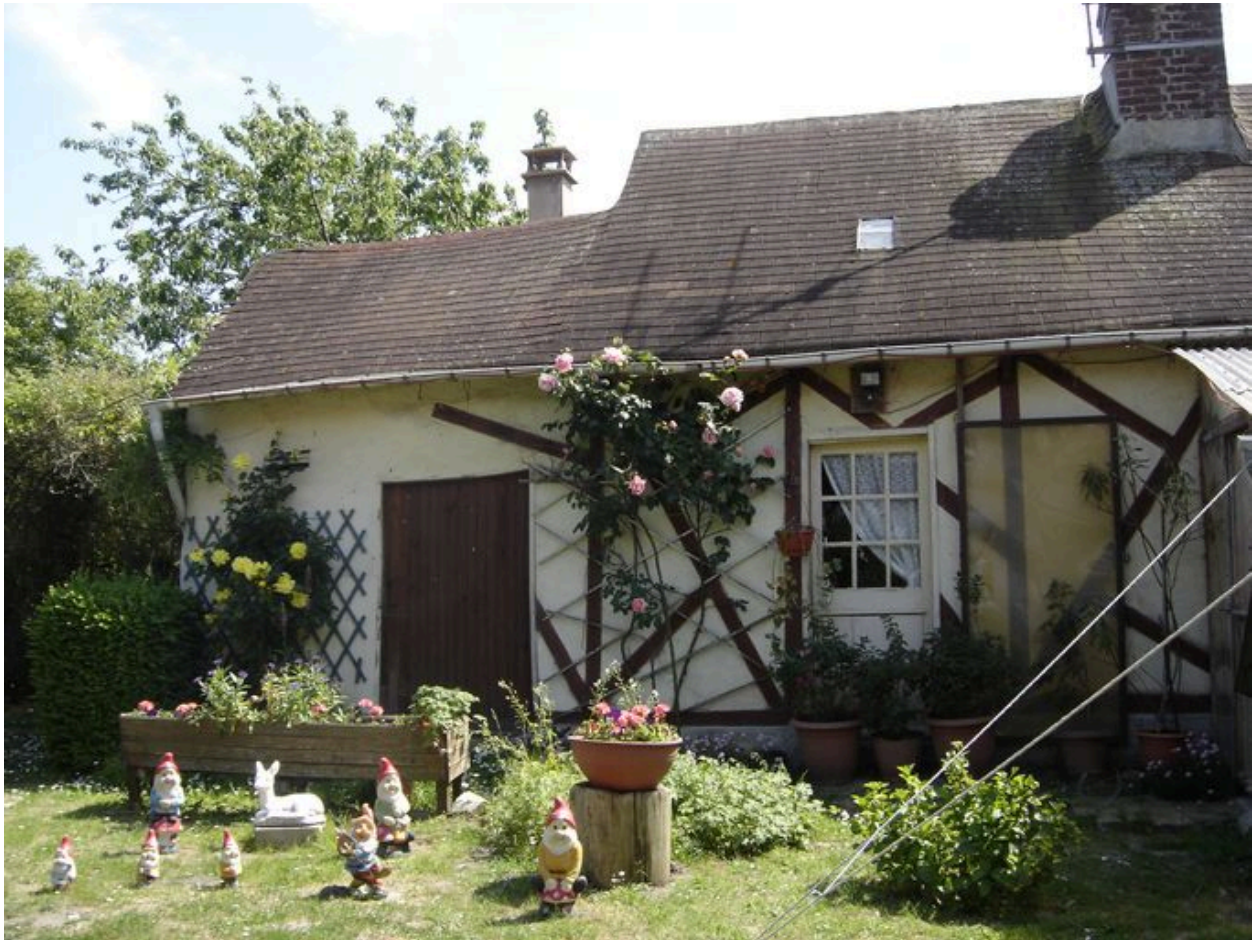
Vue depuis la cour de l'écurie accolée à la partie habitable.
