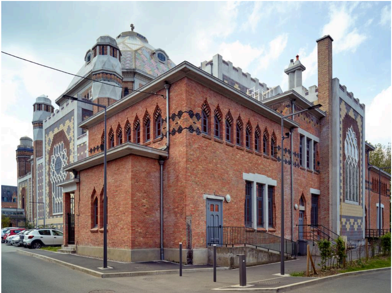
Vue de trois-quarts de la façade est depuis l'angle sud-est.
