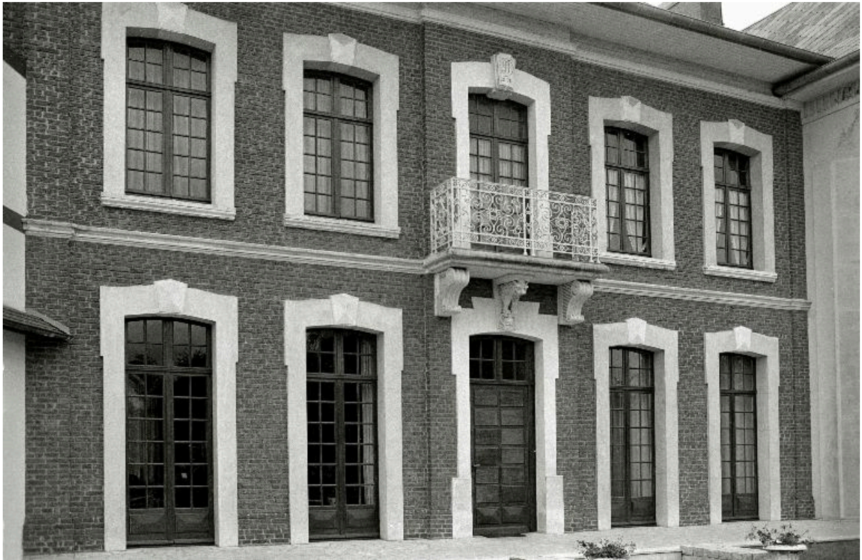
Élévation antérieure, en 1990.
