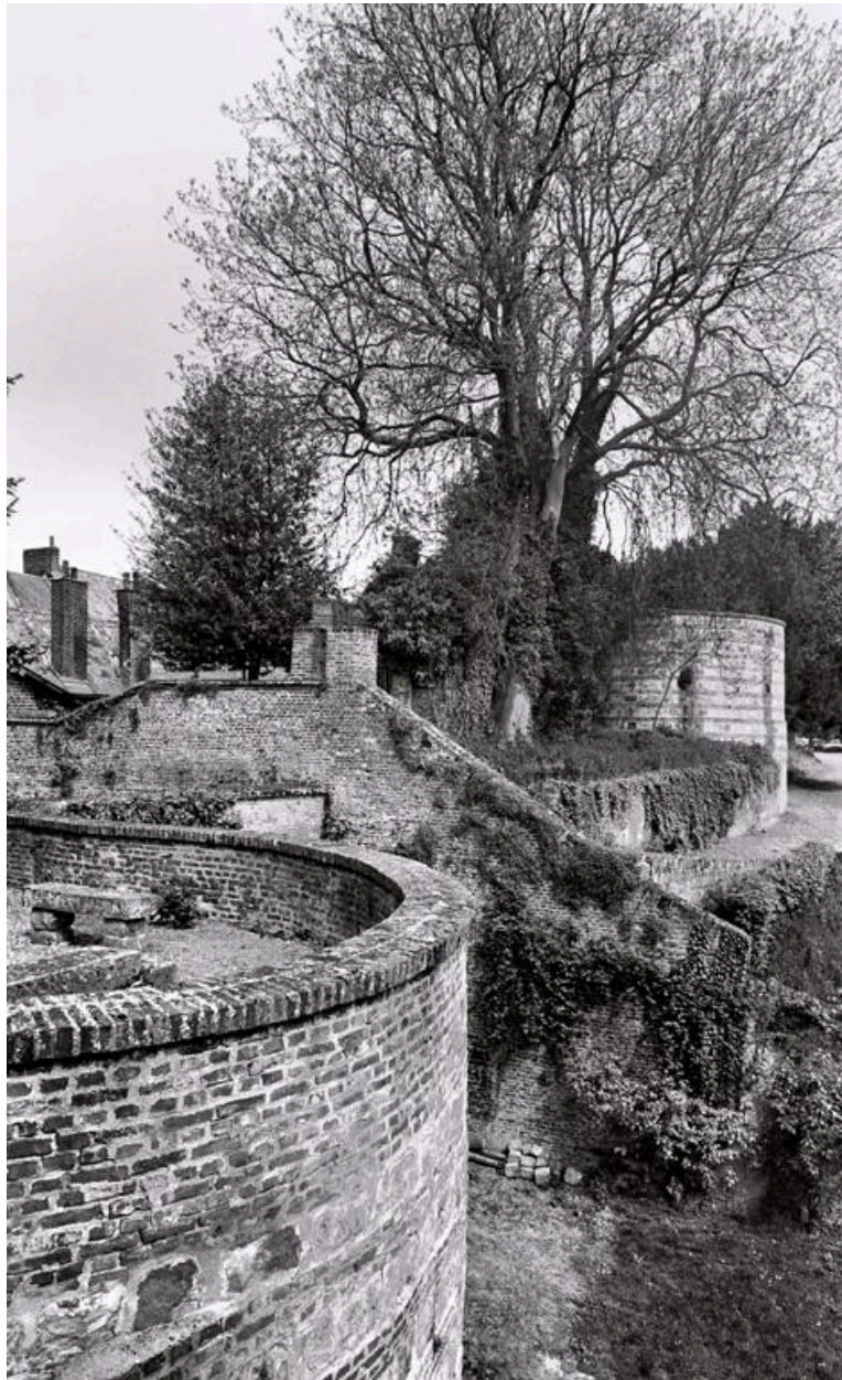
Détail d'une tour des fortifications de la ville.
