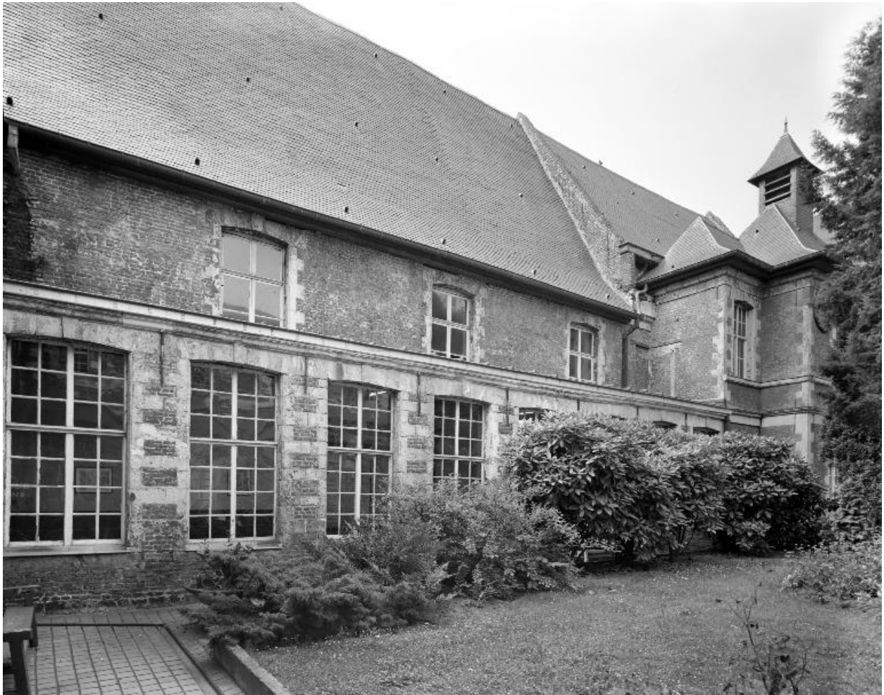
Bâtiment bordant le côté sud de la cour d'honneur, élévation sur la cour.
