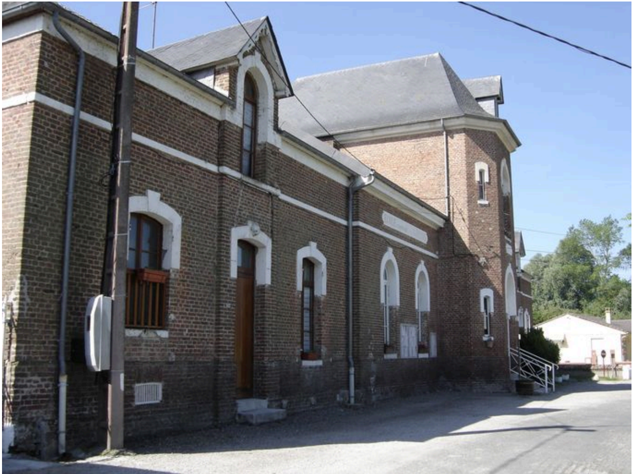
Vue sur l'aile sud.
