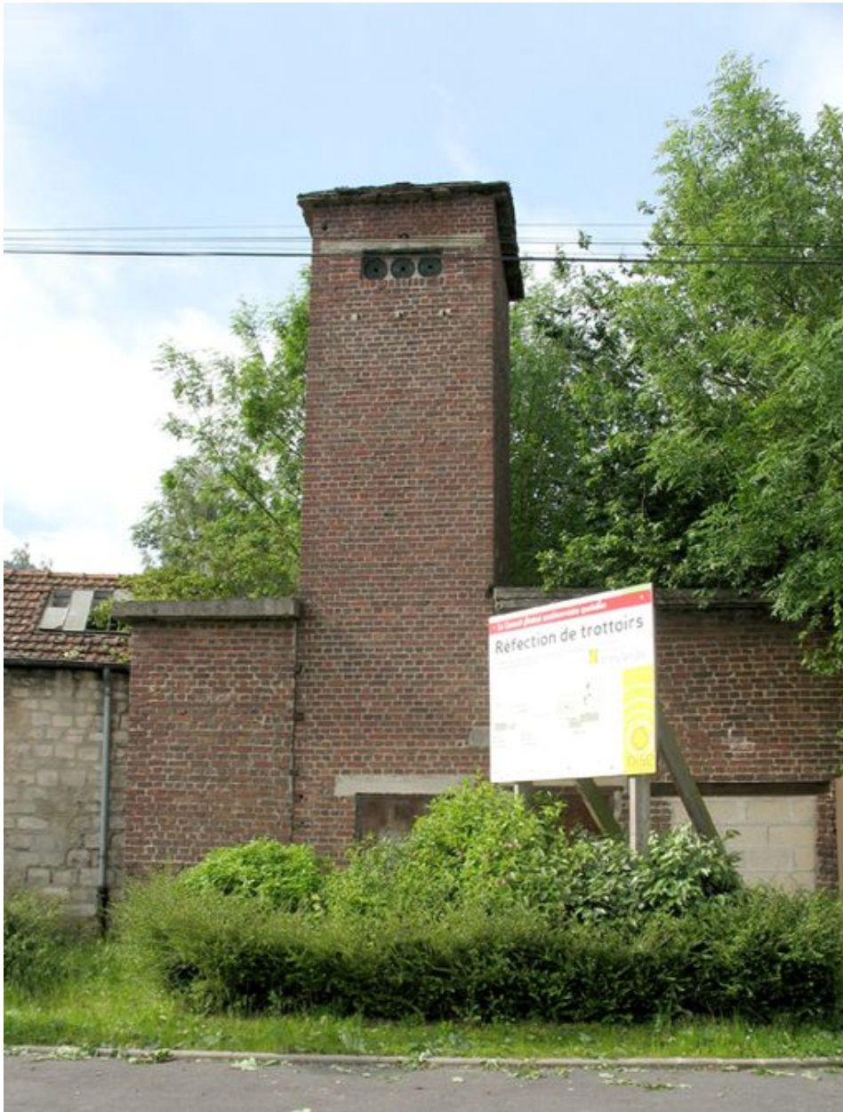
Transformateur électrique construit sur la commune de Monchy-Saint-Eloi.
