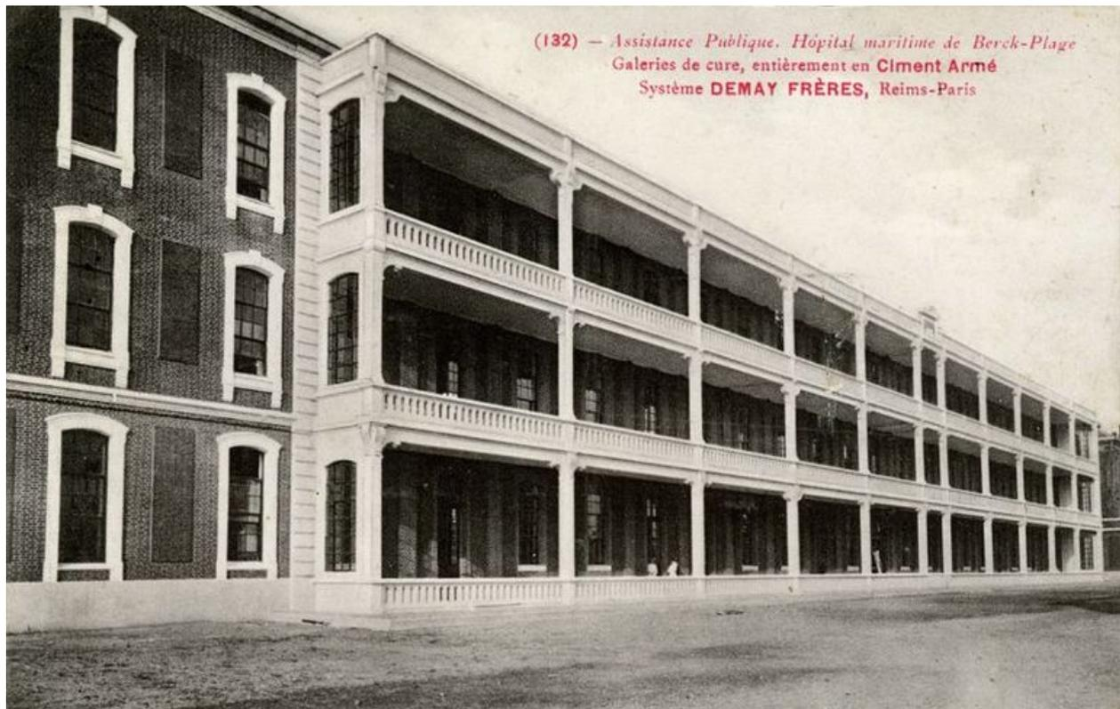
Corps de logis méridional de l'édifice primitif, état après l'ajout en 1913 de galeries de cure superposées en béton armé sur une partie de sa face sud, détail de l'élévation de ces galeries, vue prise de trois-quarts gauche.
