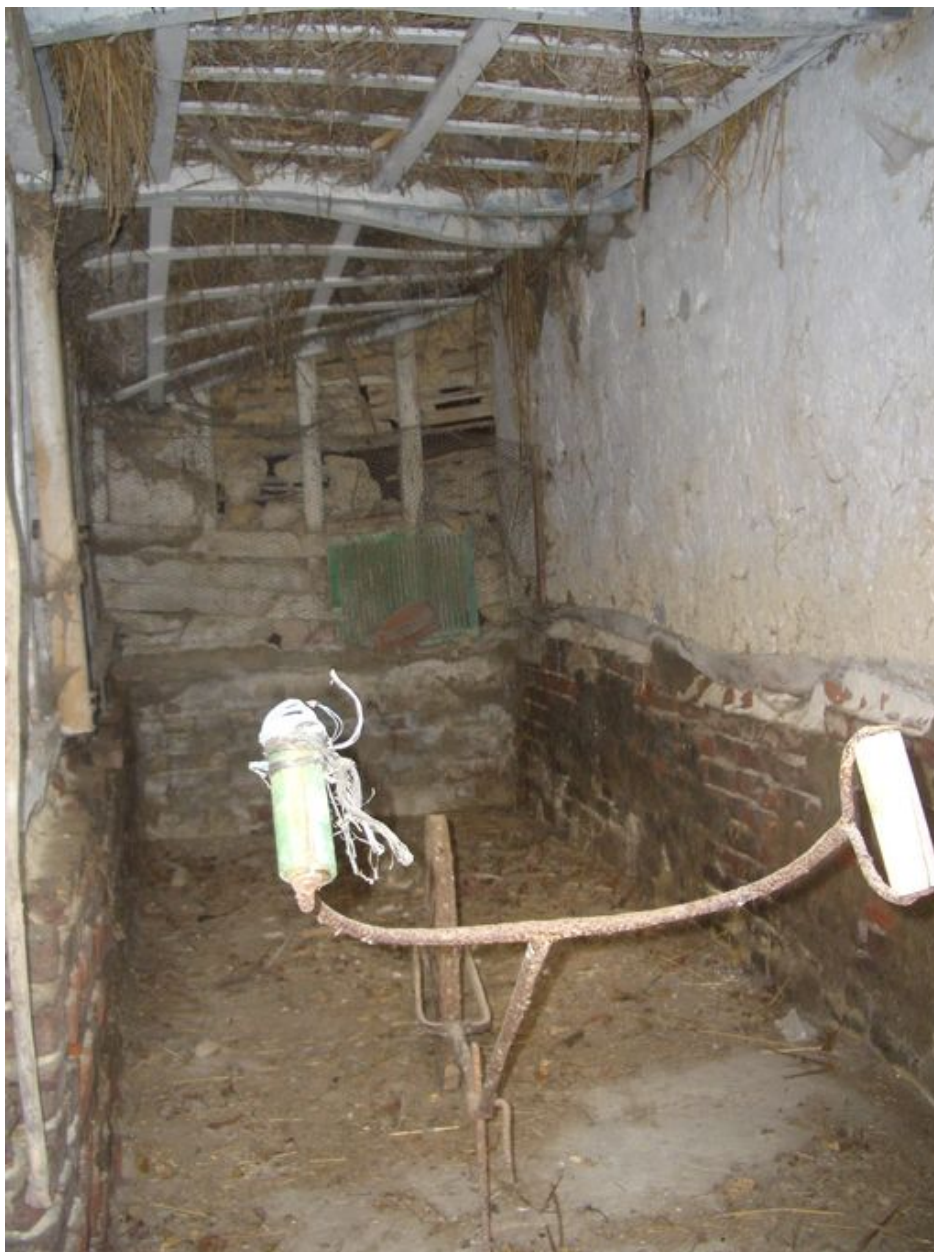
Vue intérieure d'une étable à cochon.
