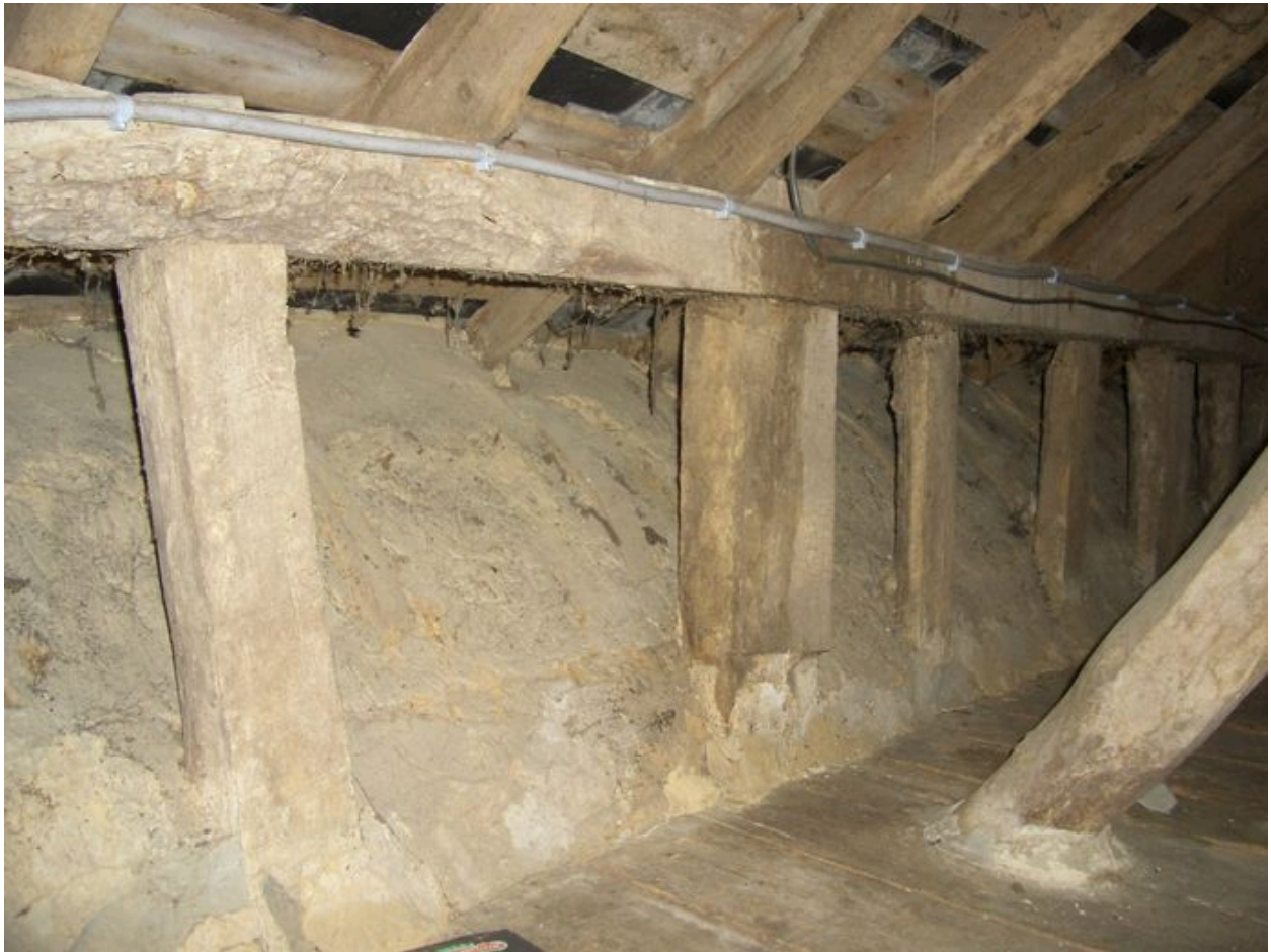
Vue depuis le grenier du système de corniche arrondie.
