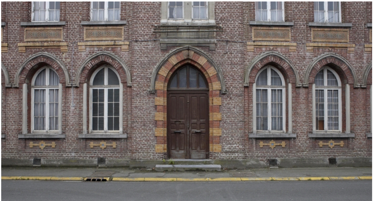
Le rez-de-chaussée de l'entrée principale.
