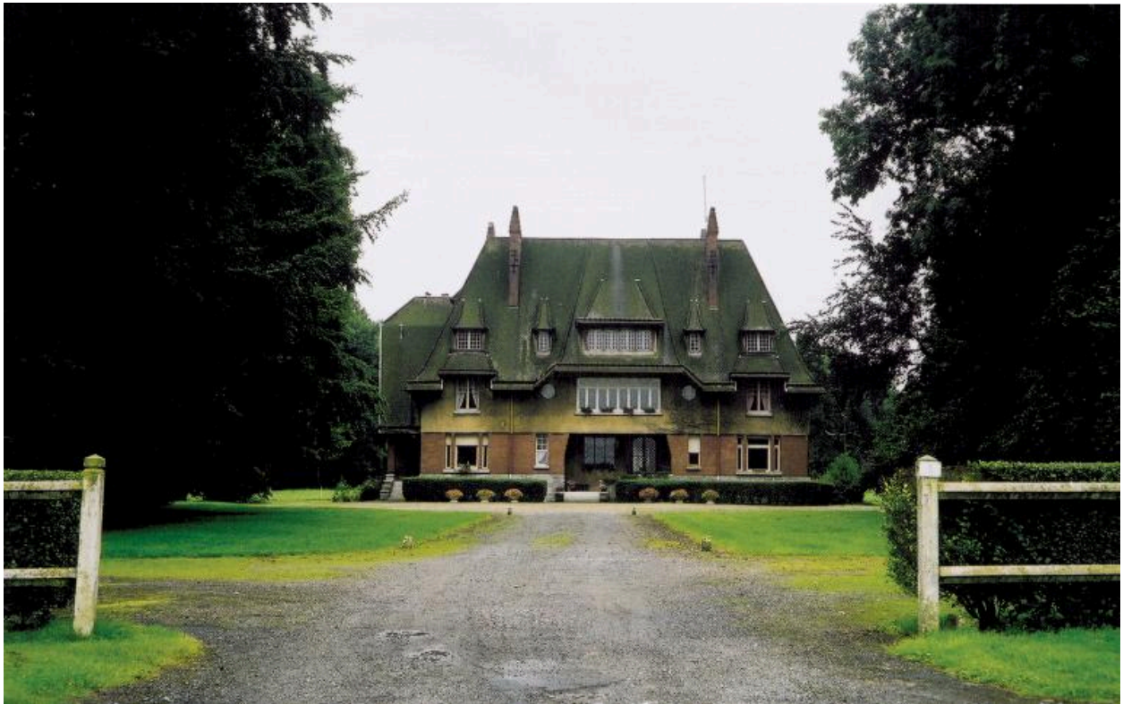
Façade principale nord.
