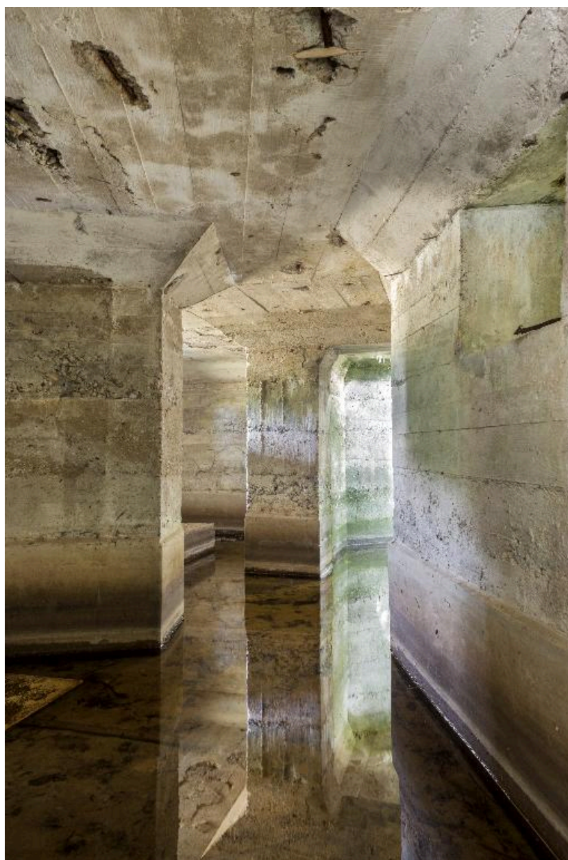
Vue intérieure vers l'entrée est
