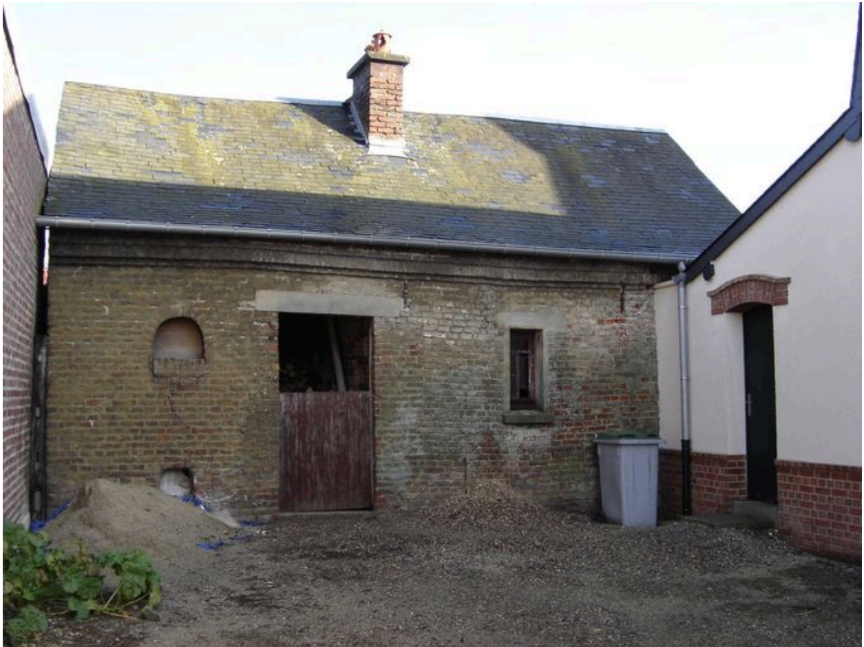
Vue de l'annexe agricole en fond de cour.
