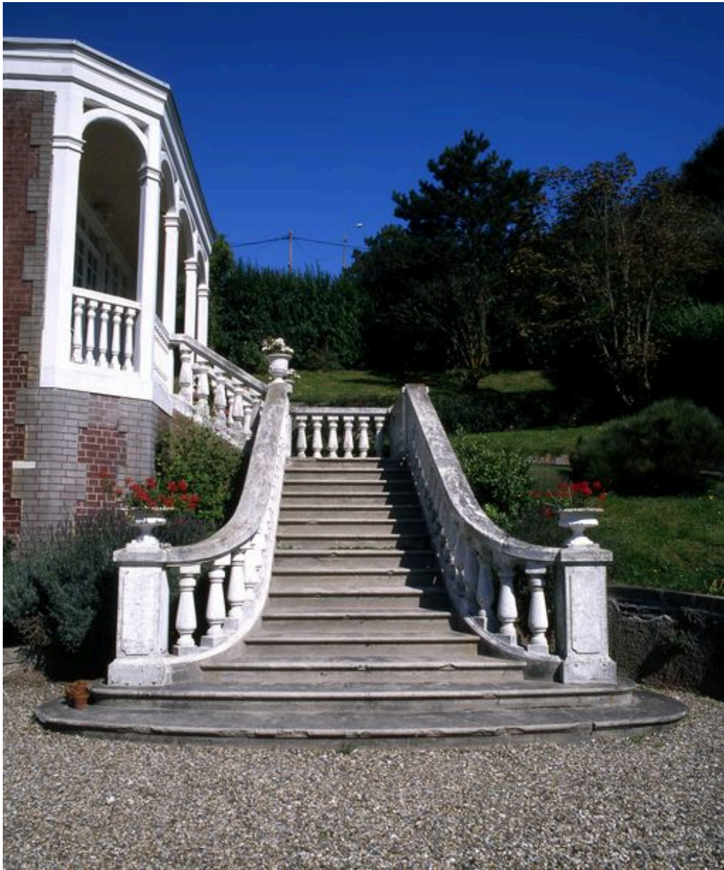
Détail de l'escalier d'accès à la terrasse couverte.
