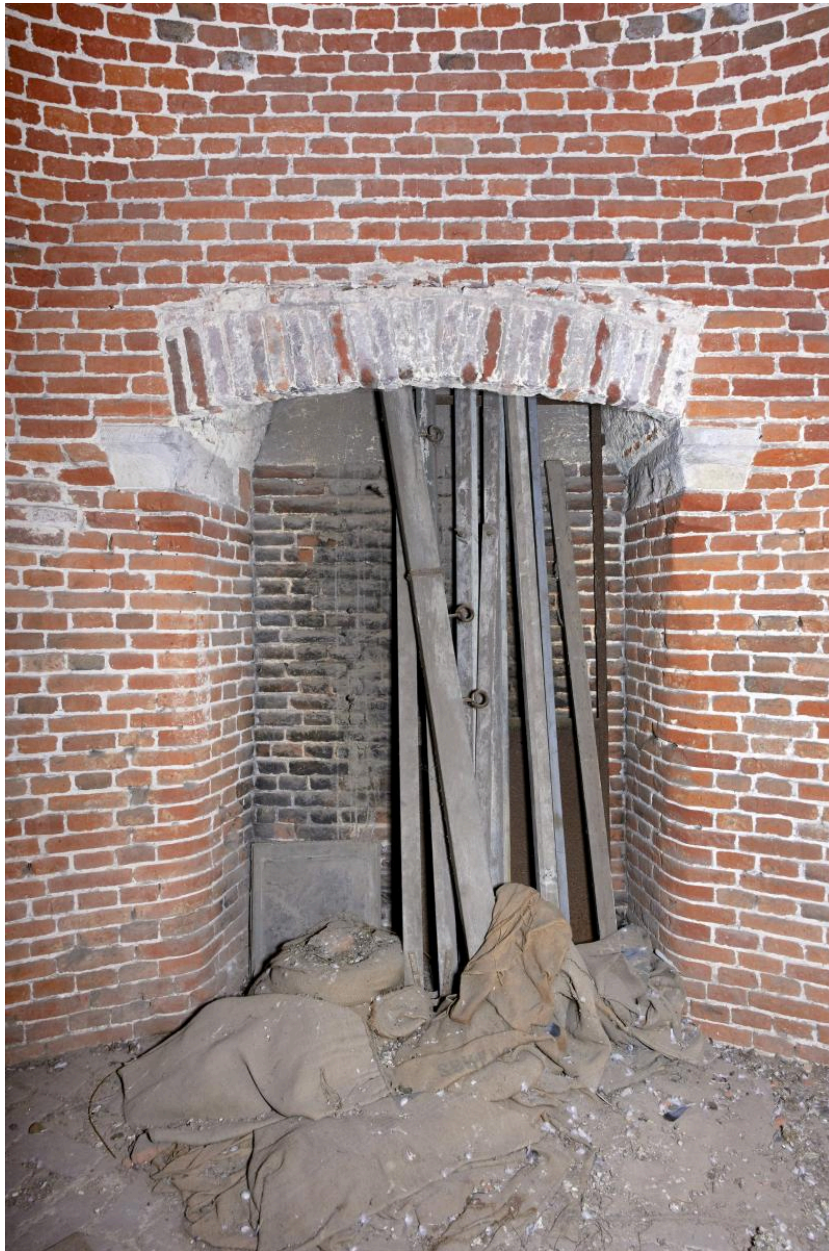
Niveau principal (R+1). Cheminée.
