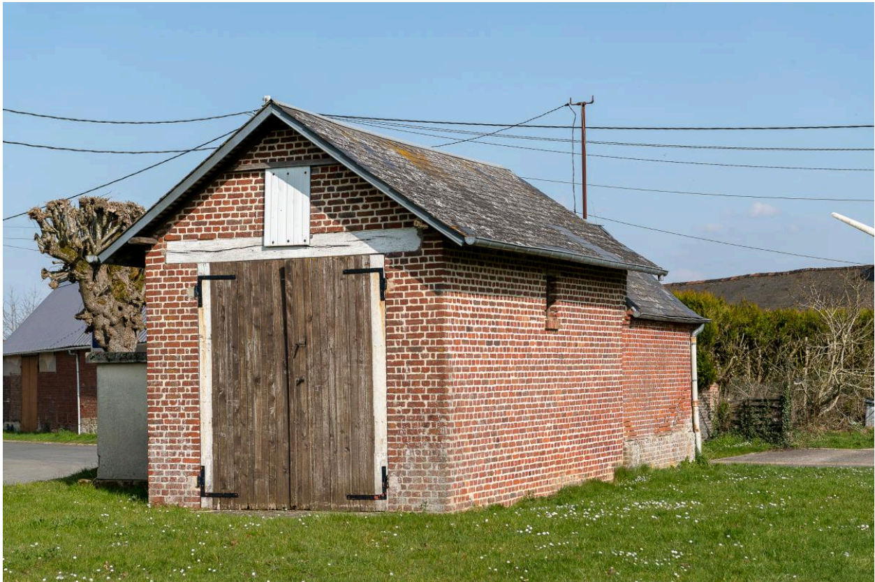
Remise des pompes à incendie, vue depuis l'ouest.
