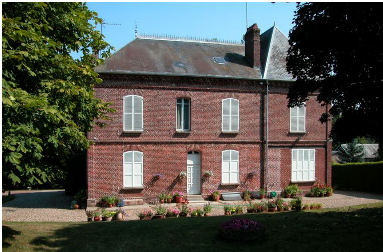
Façade sud de la maison patronale principale.
