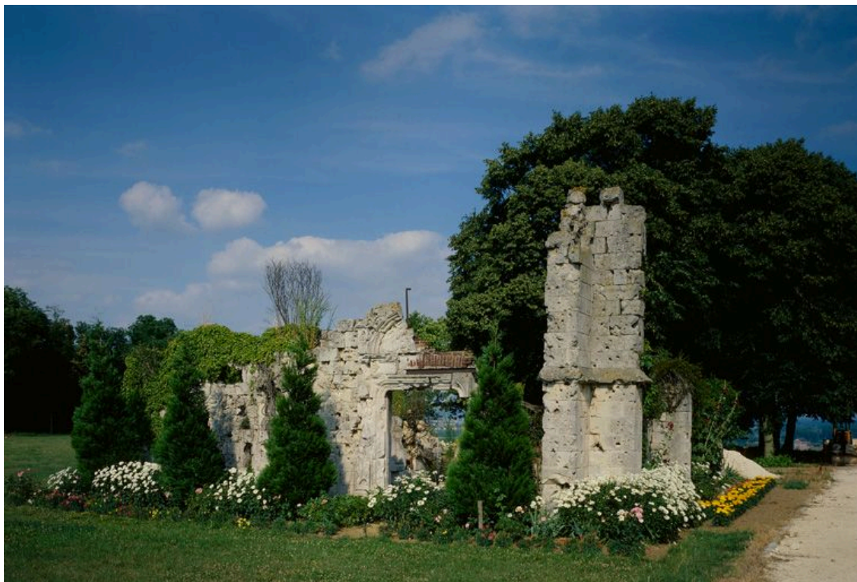
Vue de la chapelle en ruines (AP).
