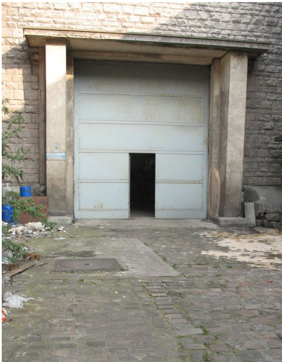
Porte d'entrée des entrepôts Boufflette.
