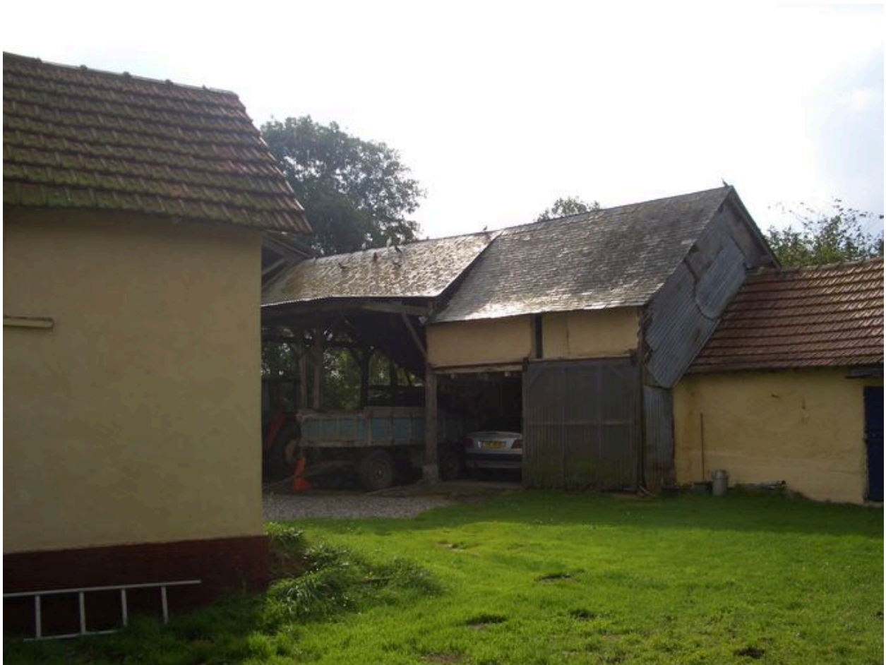
Vue du hangar en fond de propriété.
