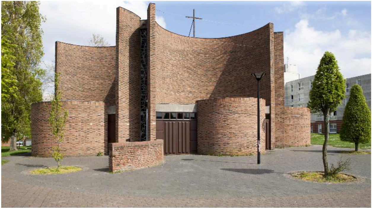
Élévation sud-ouest, avec l'entrée de l'église.
