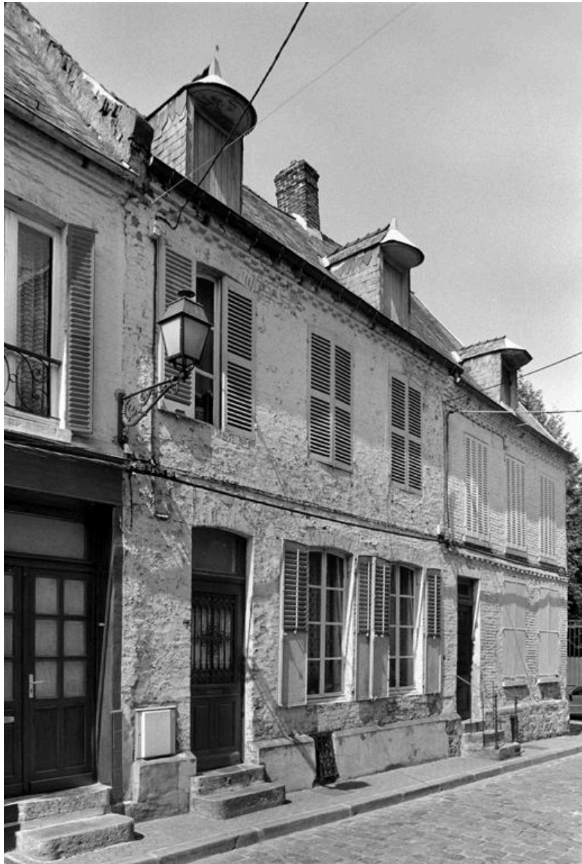
Vue de la façade principale sur rue.
