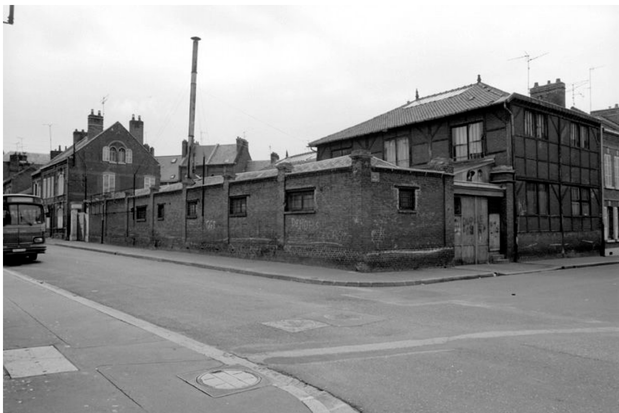
Ateliers de fabrication, flanc nord est.
