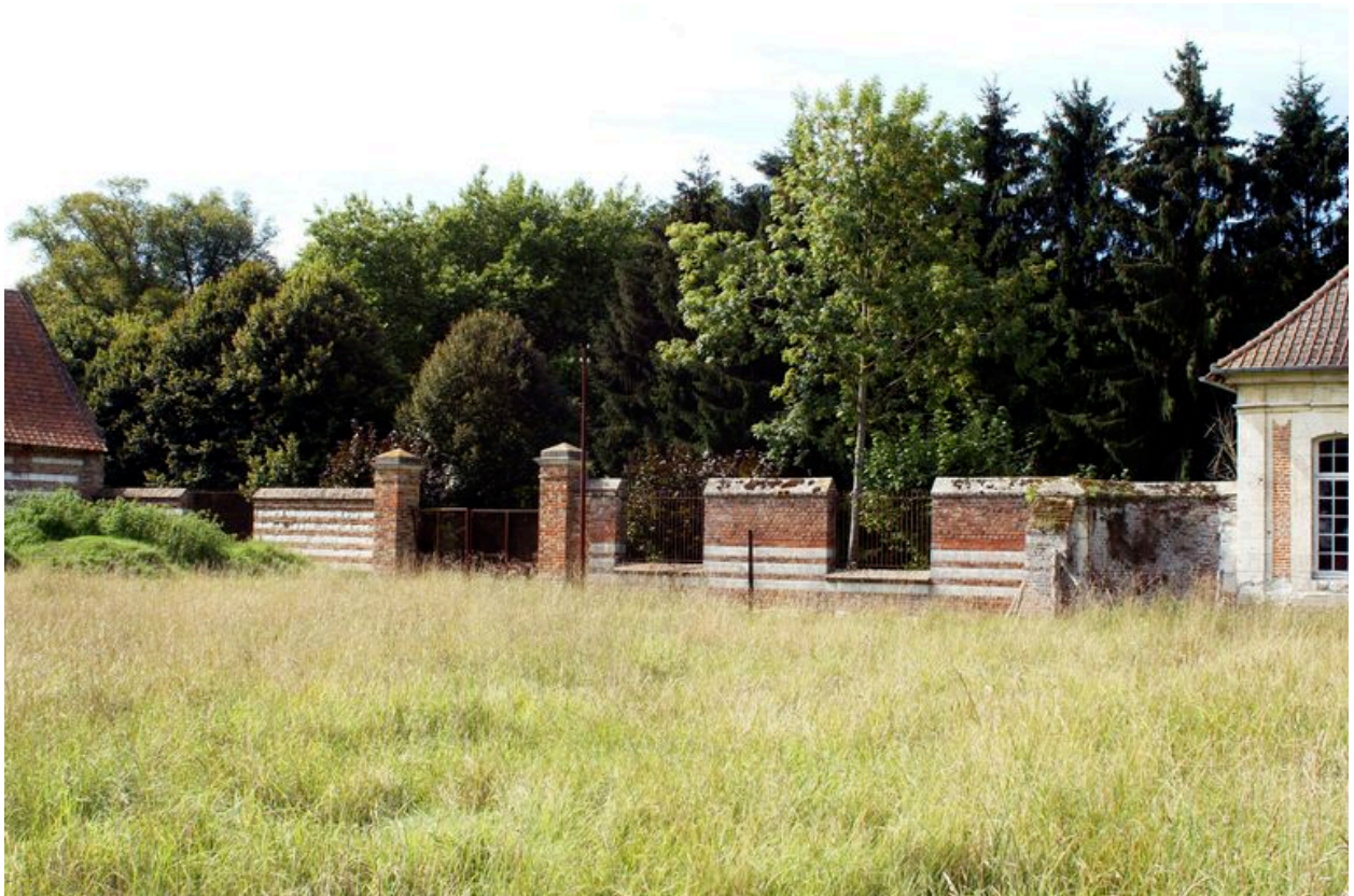
Mur de clôture du potager, intérieur.
