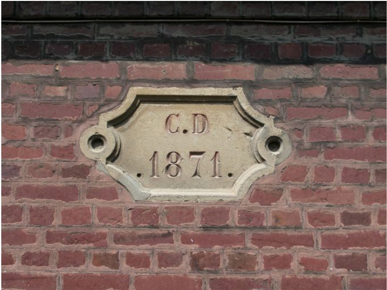
Détail des initiales et date portée 'C.D. 1871' sur le corps de bâtiment en façade postérieure.
