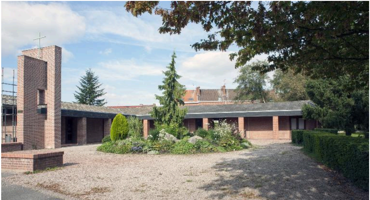
Élévation antérieure de la chapelle.
