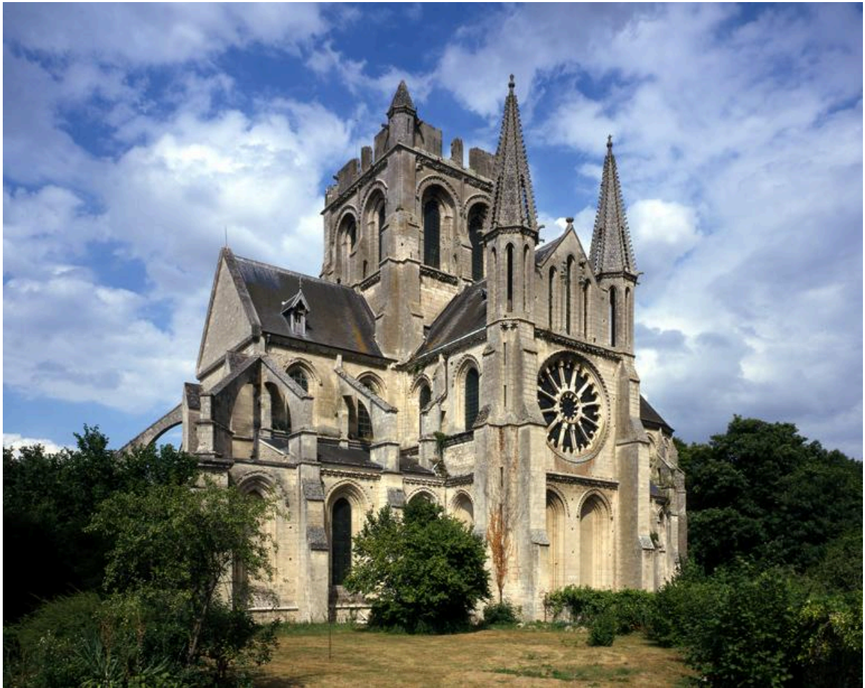
Vue de l'élévation sud.
