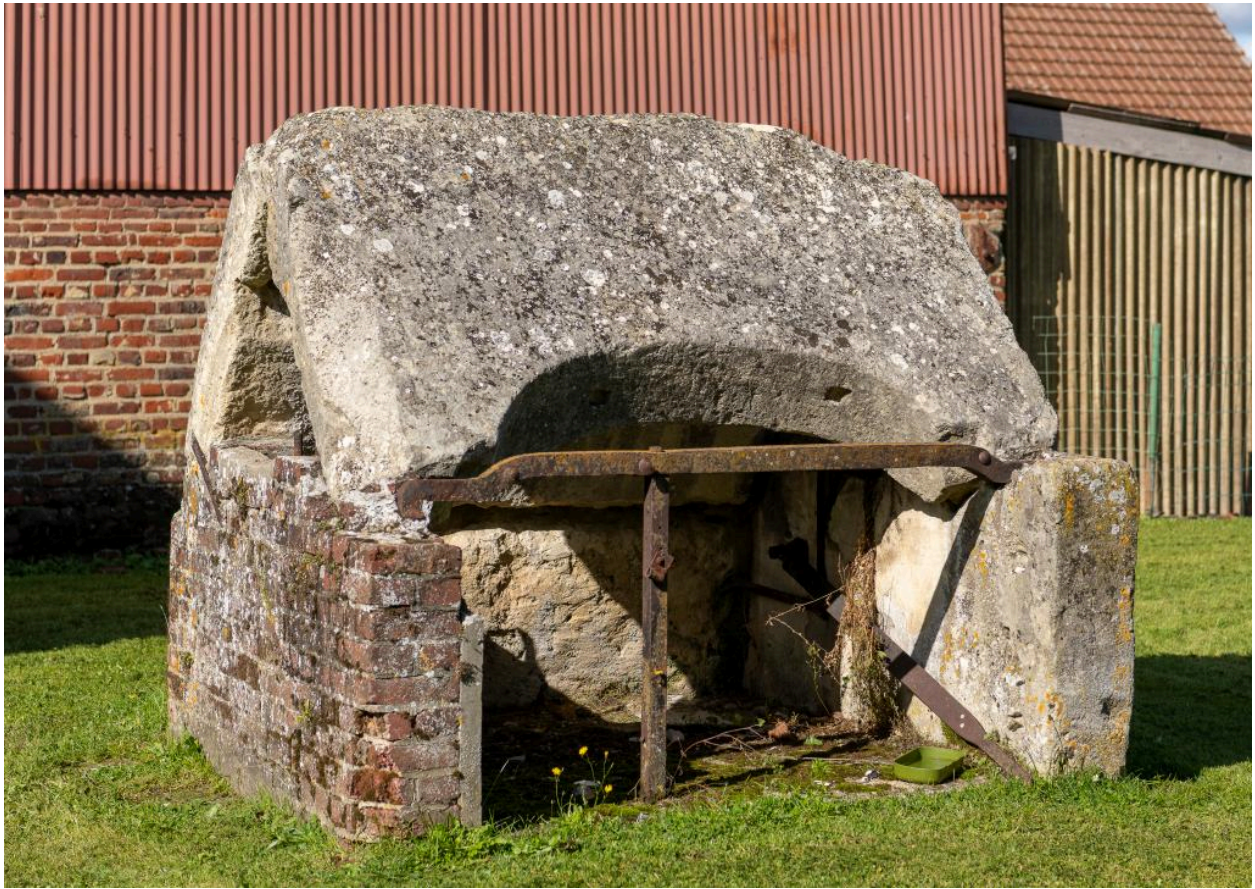
Ancien puits comblé, en face du n°30 Grande Rue, vue depuis le sud-est.
