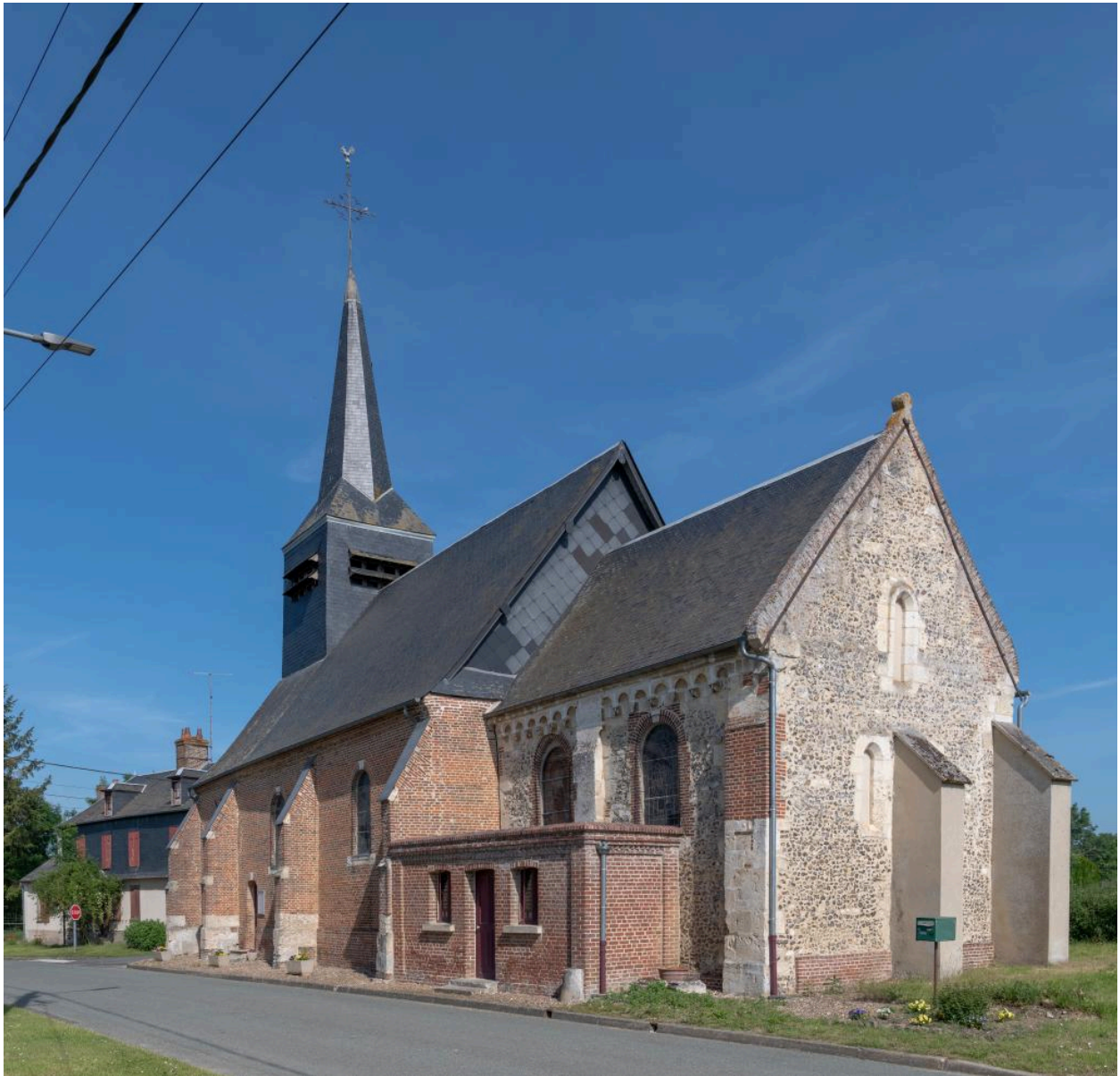
Vue de l'église depuis le sud-est.
