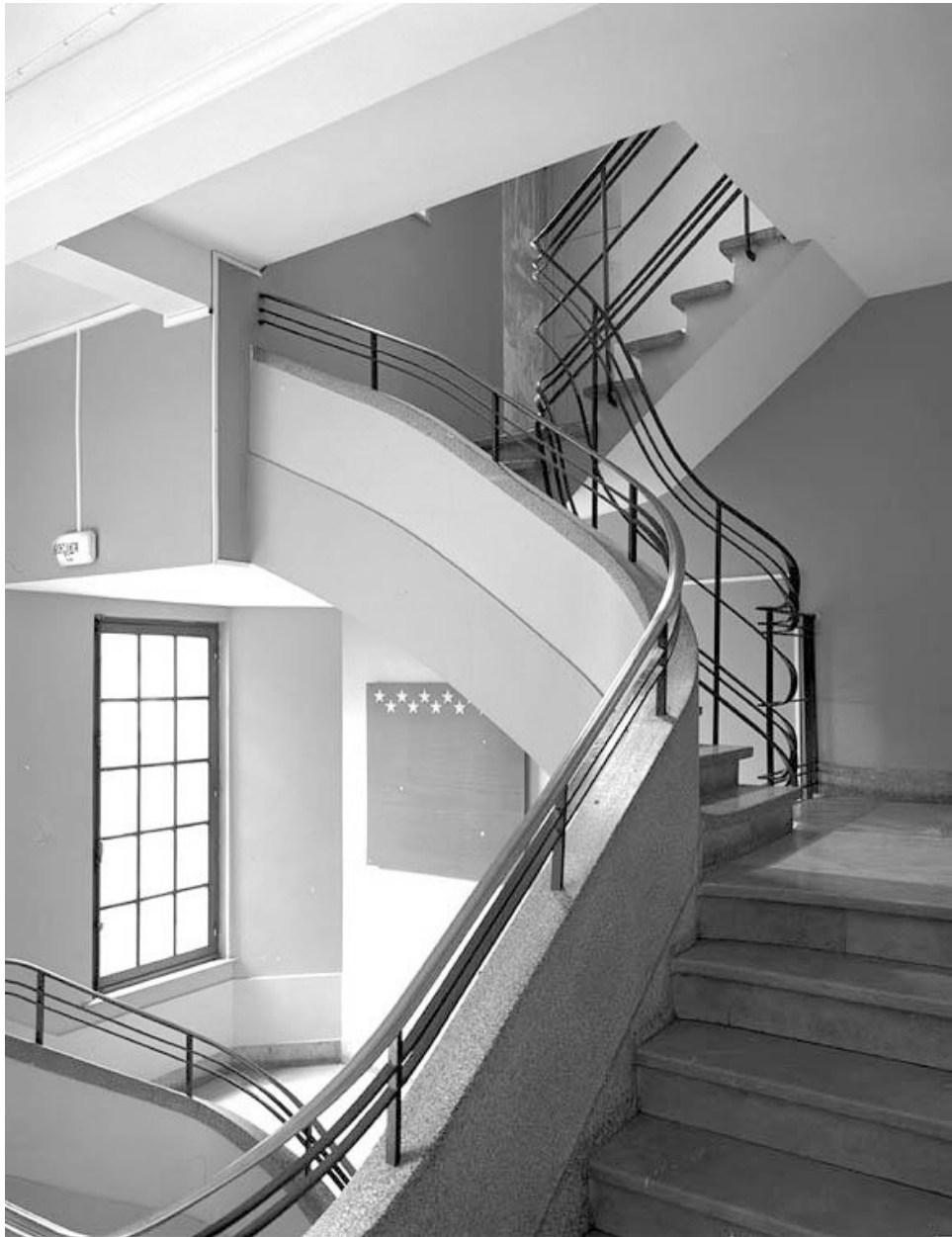
Vue générale de l'escalier desservant l'aile sud.
