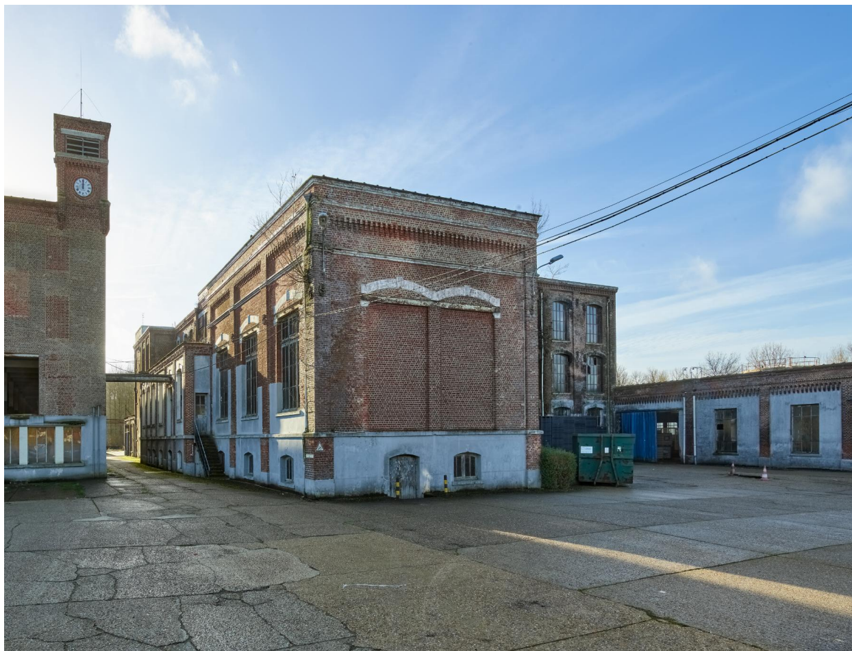
Façade nord de l'ancienne chaufferie (bâtiment K).
