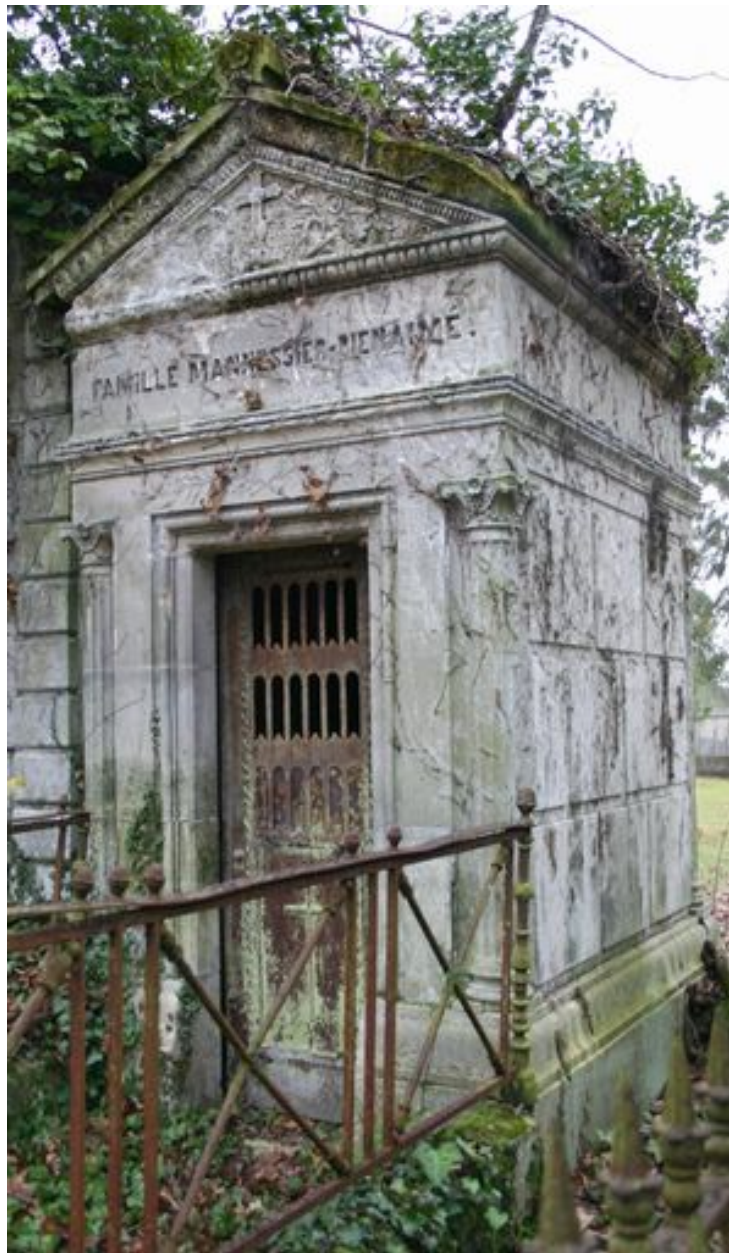
Vue rapprochée du tombeau en forme de chapelle, depuis le côté.
